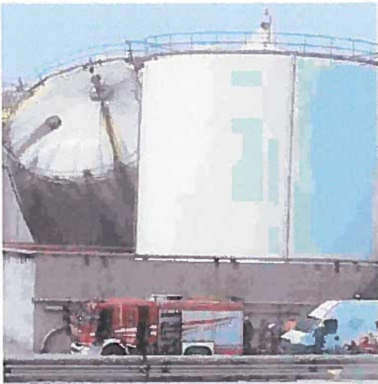
Il serbatoio esploso si è piegato su quello accanto
