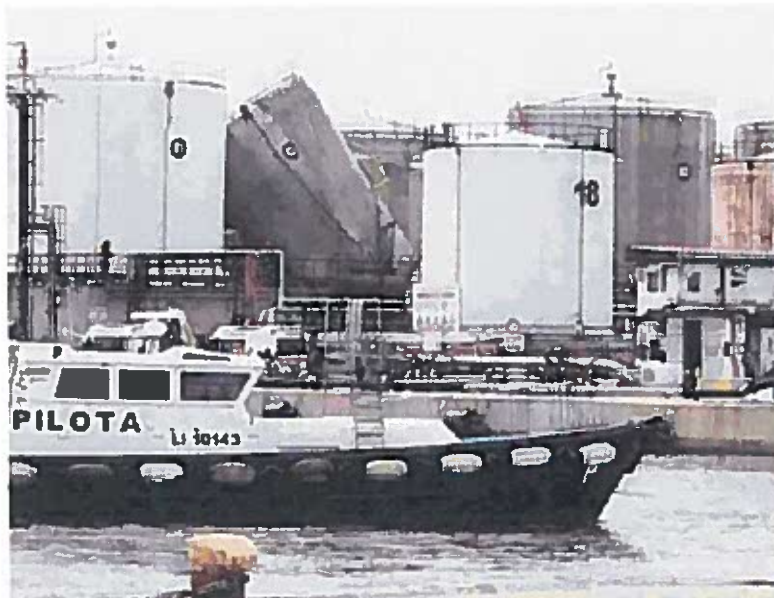
La cisterna rimasta inclinata, dopo l'esplosione. Nella foto piccola, l'arrivo al porto del sindaco Filippo Nogarín
